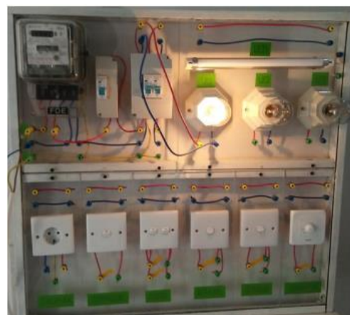
Gambar 16 Pemasangan KWH Meter dan MCB
