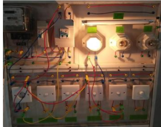
Gambar 19 Pemasangan dua saklar tukar, satu lampu, dan satu stop kontak
