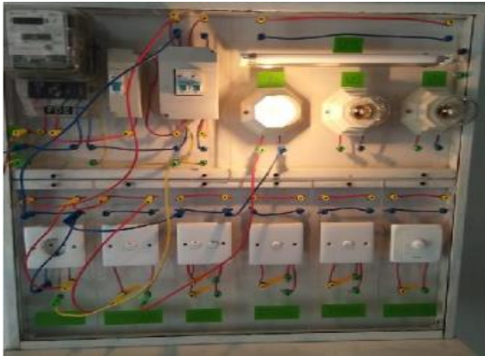
Gambar 17 Pemasangan Satu Saklar Tunggal, Satu Lampu dan Satu Stop Kontak
