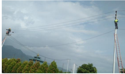
Gambar 2. penarikan kabel SUTM di Jaringan SUTM Feeder Mata Air
